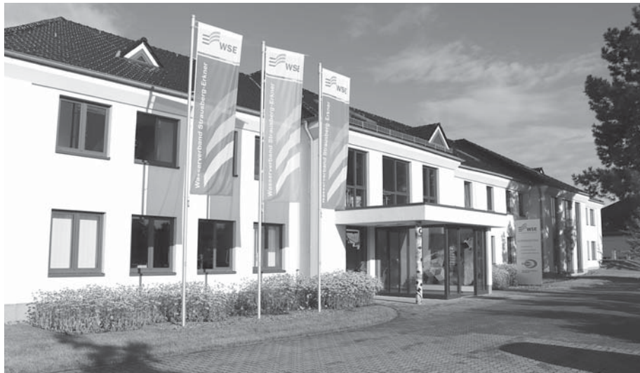
Das Kundencenter des Wasserverbands Strausberg-Erkner befindet sich in Strausberg.
