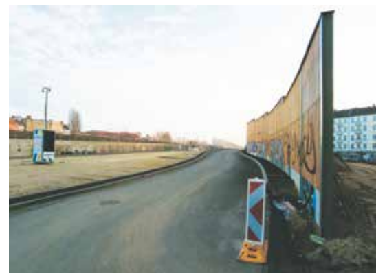
A100-Baustelle in Treptow, hier soll die Stadtautobahn vorerst enden. Foto: Tobias Trommer
